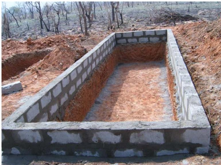
**Photo 8 : Trous d'infiltration des boues de vidange**
