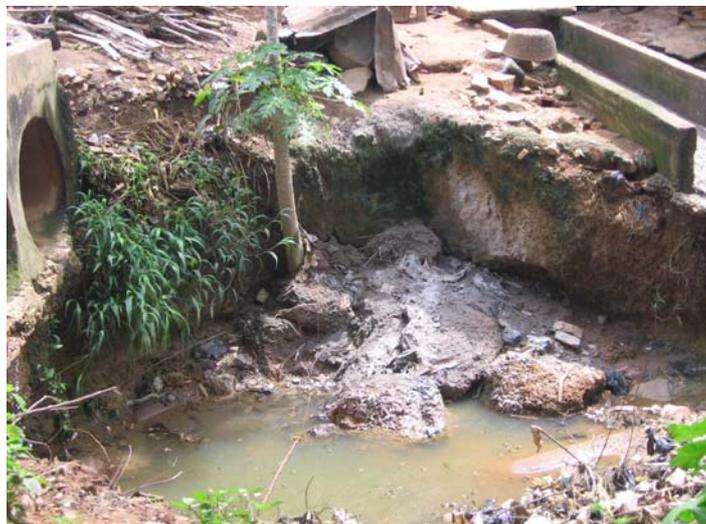
**Photo 1 : Canaux d'évacuation d'eaux pluviale dégradés**
