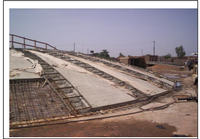
Photo 9: Panneaux de coupole préfabriquée
