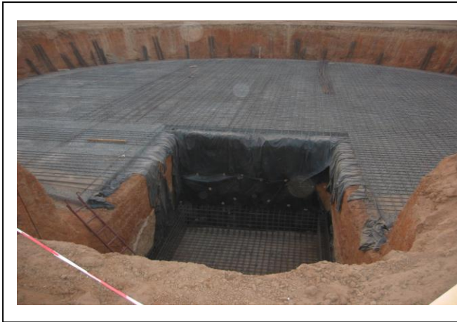
Photo 14: Dispositif d'étanchéité de la bache
