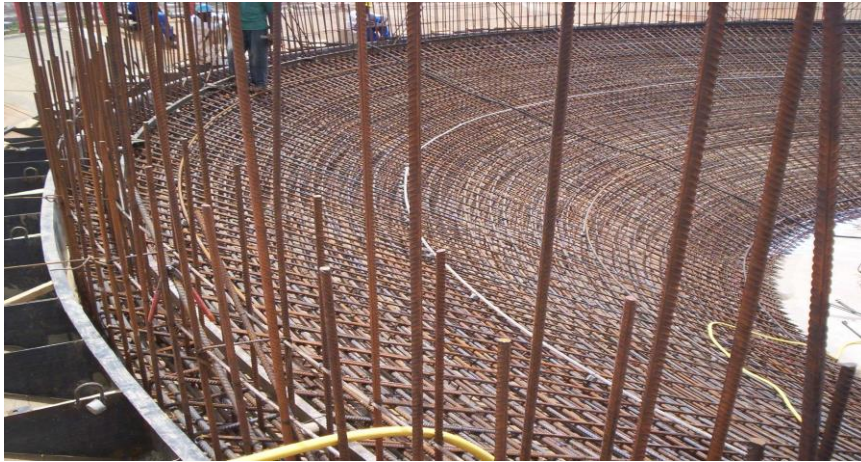
Photo 6:Ferraillage de la partie tronconique
