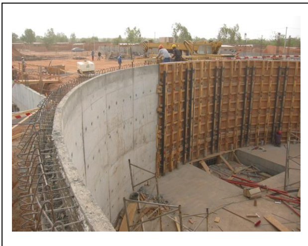
Photo 16: Armatures de la ceinture supérieure
