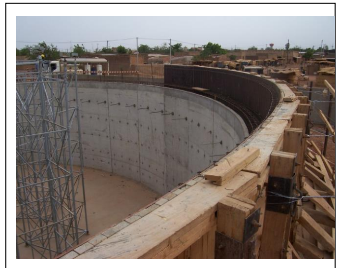
Photo 13: coffrage de la ceinture de la bache
