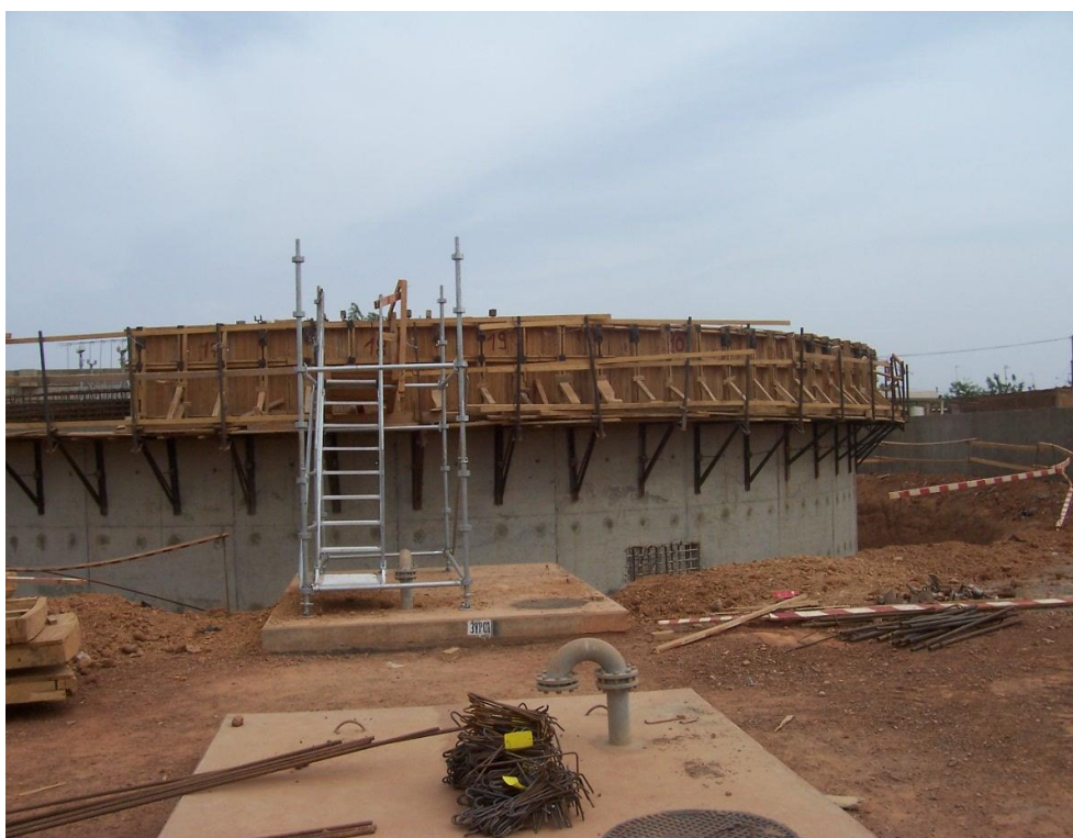
Photo 2 : Vue d'une bache de stockage en construction
