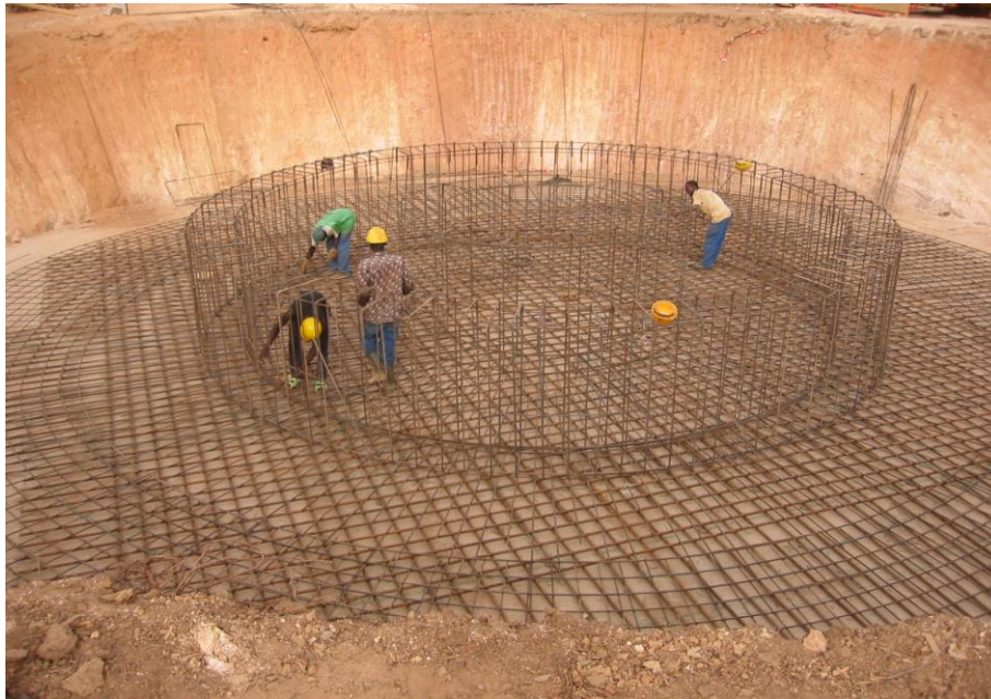
Photo 4: Ferrailage du radier
