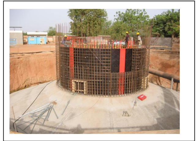
Photo 15: ferrailage du fut du château
