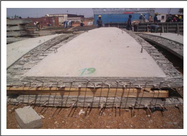
Photo 8: Panneaux de coupole préfabriqués
