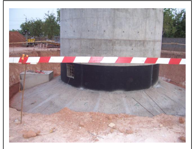
Photo 11: Fond tronconique et fût du château
