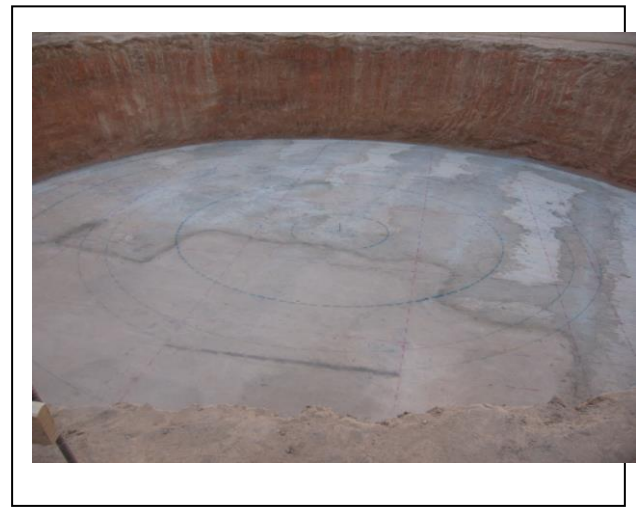
Photo 17: Radier de la bache de stockage
