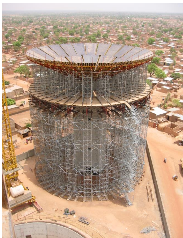
Photo 1: Vue du château en construction. Le coffrage du fond tronconique sur échafaudage métallique
