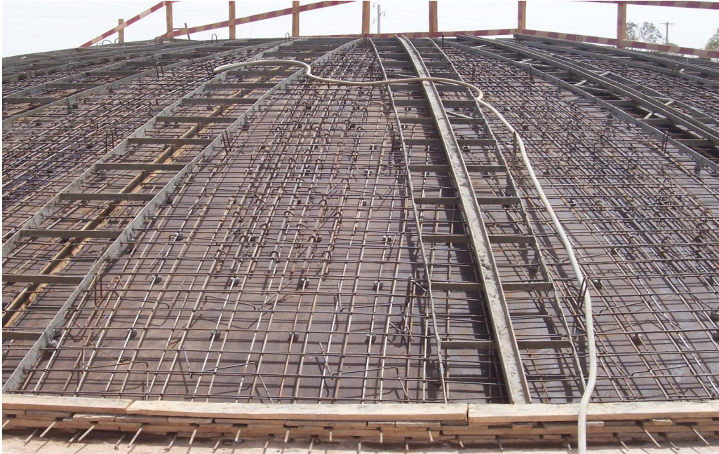
Photo 3: Ferrailage des panneaux de la coupole
