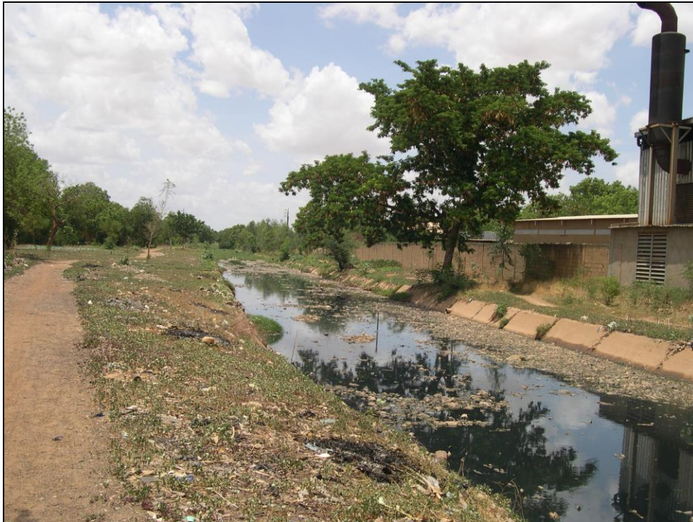
Photo 5: Partie aval du canal Central
