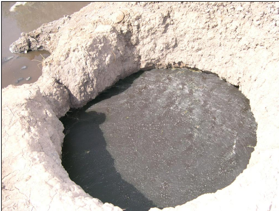
Photo 7: Puit de stockage d'eaux usées sur un site de maraîchage
