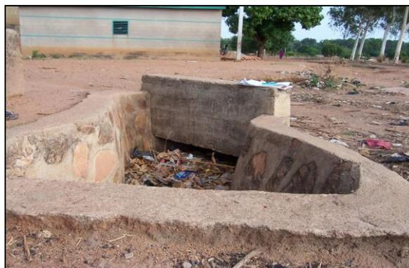
*Figure 32: Comblement d'un caniveau par les DS*
