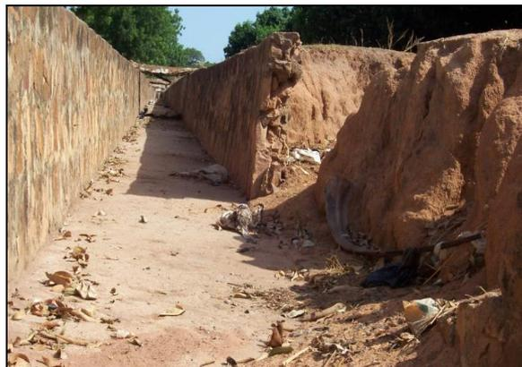
*Figure 31: Tronçon d'évacuation d'EP dégradé*
