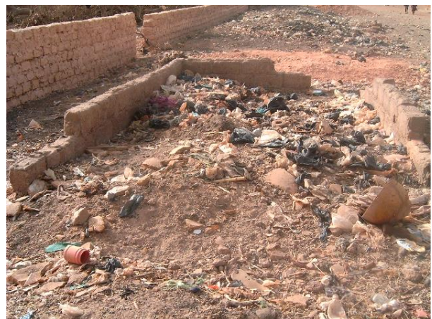
Photo 2 les bacs souffrent d'un manque d'entretien
