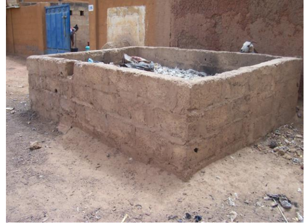
Photo 7 fosse fumière en parpaing
