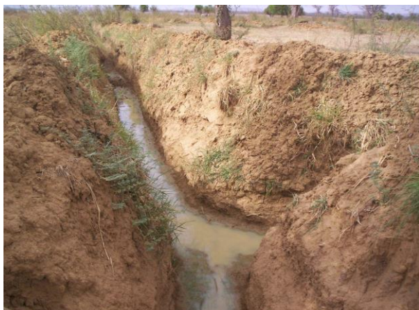
Photo 6: Canal d'amenée d'eau
