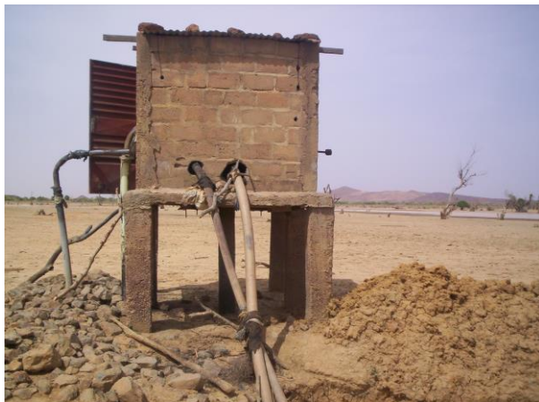
Photo 4: Station de pompage sur le lac BAM
