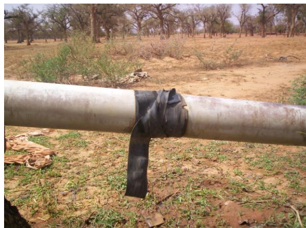
Photo 7: Raccordement des conduites
