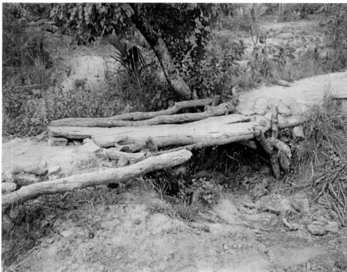
Photo 3 : Ouvrage de franchissement aménagé par les populations
