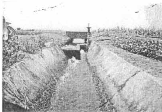
Photo 7 : pertuis sur déversoir (aval CS1)
