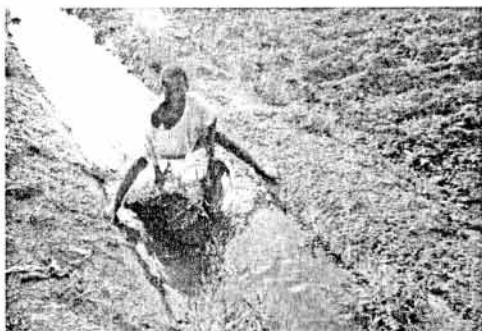
Photo 3 : canal ensasé et enherbé
