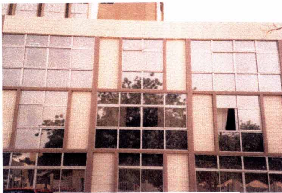
Photo N°2 : Vue de l'aile sud du bâtiment A
