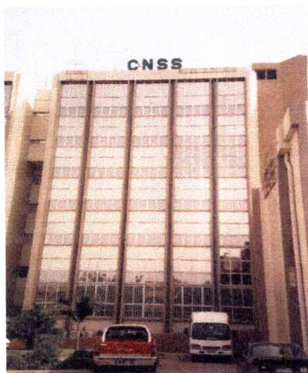
Photo N°1 : Vue de l'aile sud du bâtiment (R+6)
