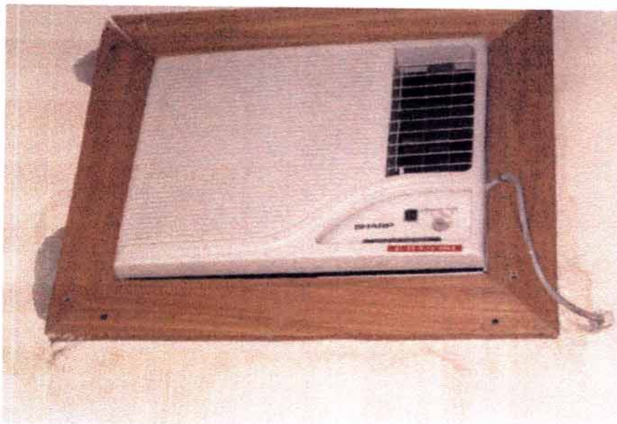
Photo N°5 : Unité intérieure d'un climatiseur fenêtre
