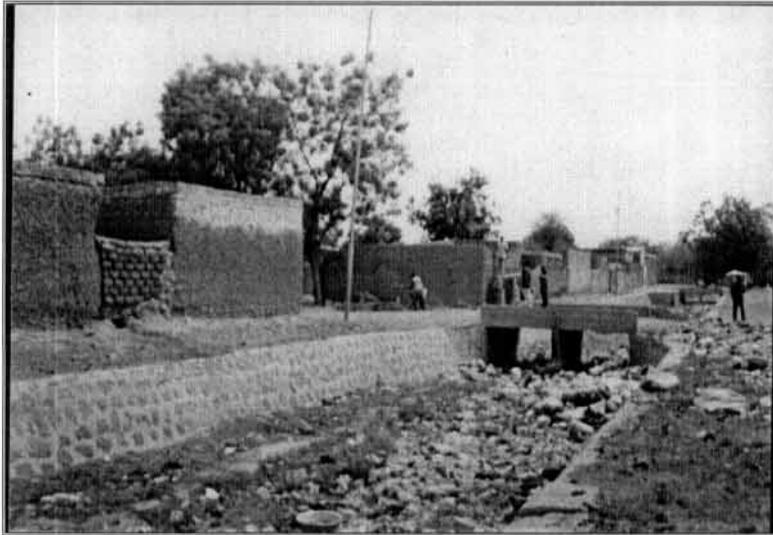
photo N°4 : Caniveaux transformés en dépôt sauvage et non nettoyés
