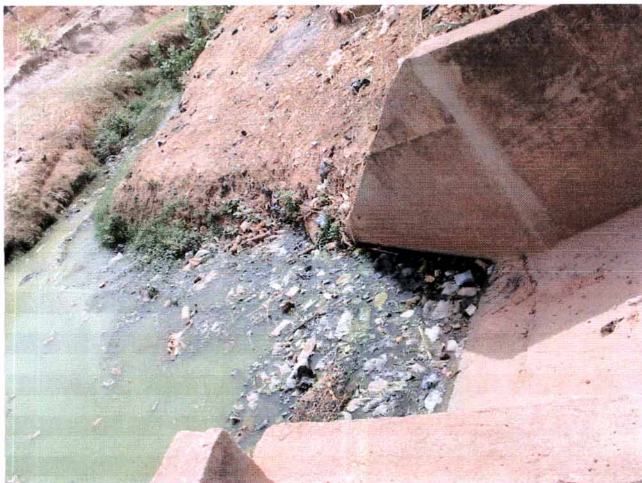
Photo 2: Caniveau débouchant sur un cours d'eau
