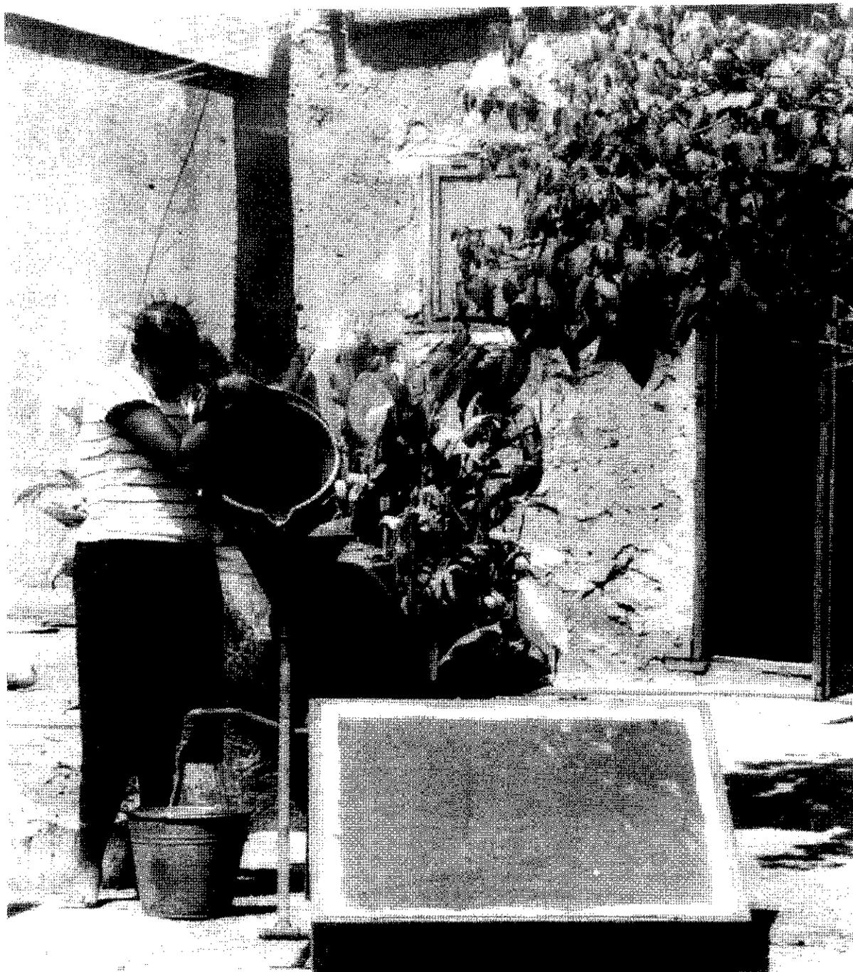
**Photo 1 : Chauffe-eau solaire capteur réservoir.**
