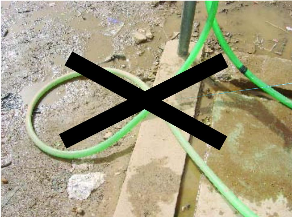
**Il est formellement interdit de laisser traîner au sol les tuyaux de distribution d'eau car vous livrerez de l'eau souillée à vos clients.**
