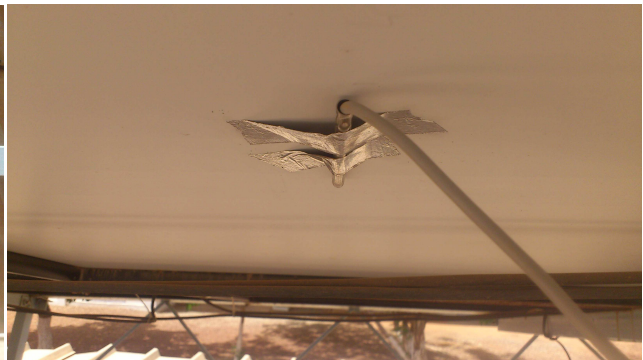
Figure 17: Sonde température module.
