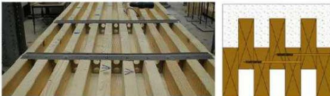
**Figure 8** - Dalle mixte bois béton nommée D-Dalle
