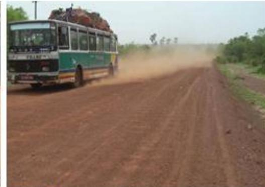
Figure3 : Tôle ondulée du au trafic
