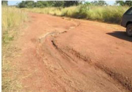
Figure2 : Ravinement longitudinal et transversal
