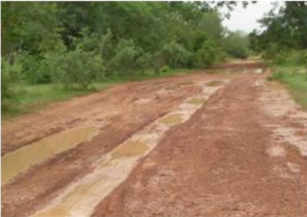
Figure 4 : Orniérage et affaïssement se transformant en borbier sous pluie
