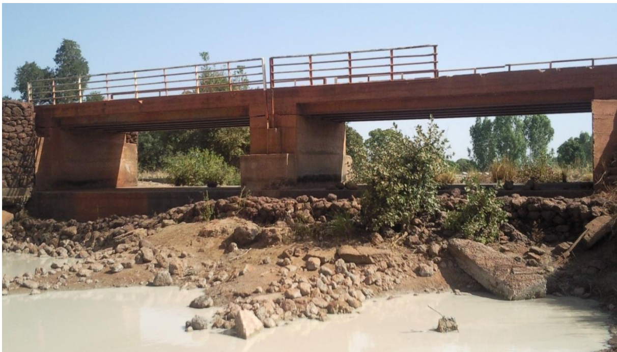
Figure 2: Vue de l'ouvrage existant
