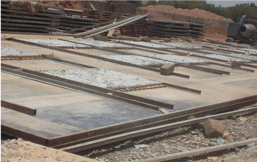
Figure 7: poste de préfabrication de prédalles
