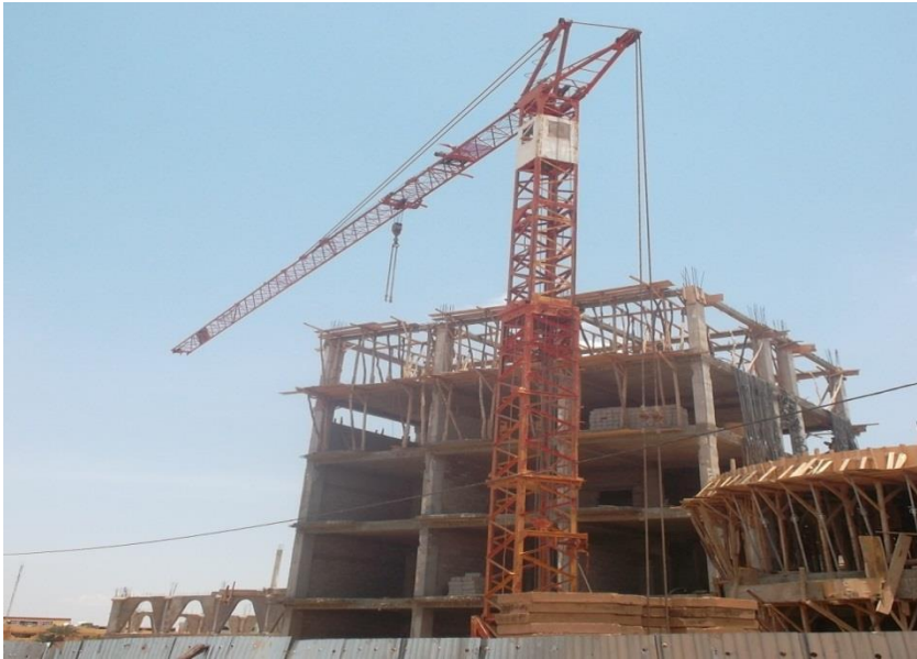
Figure 5: Grue à tour
