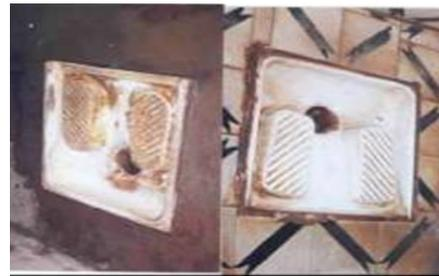
**Figure 8: WC turc en dégradation par d'eau et d'entretien**
