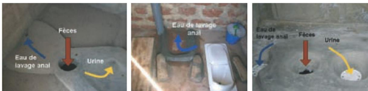
**Figure 20** : Exemple de dalle conçu avec possibilité de lavage anal.
