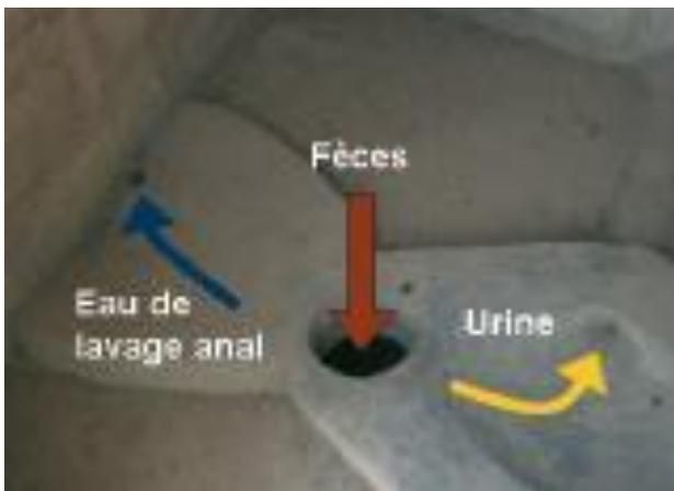
Figure 20: Latrine avec système de lavage anal 1
