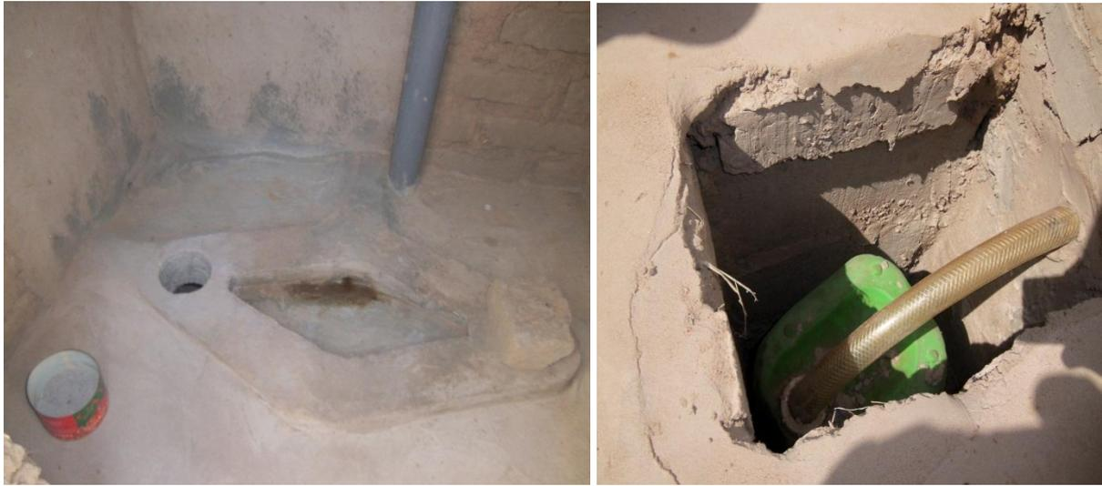
**Figure 5 : Latrine EcoSan double fosse vue de l'intérieur** **Figure 6 : Bidon de collecte d'urine**
