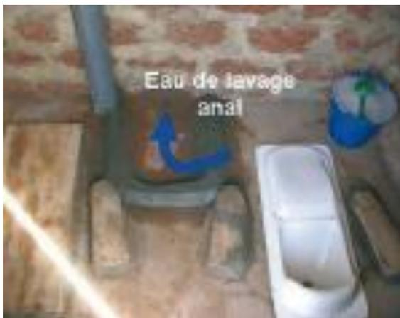
Figure 21: Latrine avec système de lavage anal 2
