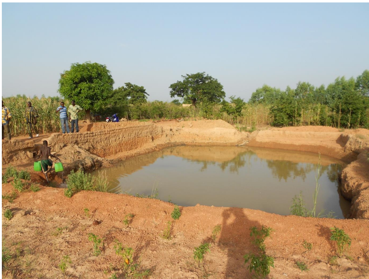
Figure 4 : Exemple d'un bassin individuel de collecte et de rétention d'eau de pluie à Rawelgué
