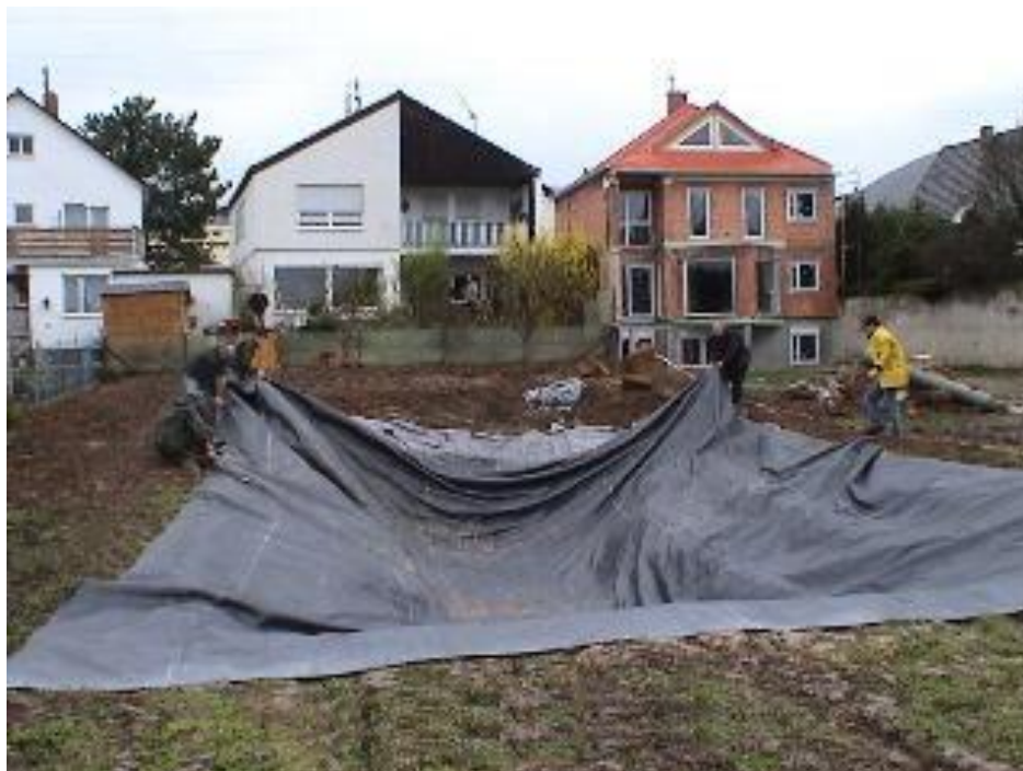
Figure 9 : Bâche en EPDM fabrication Gasconature
