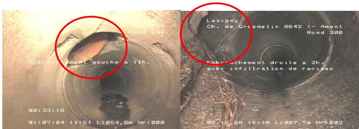
Figure 21: Illustration de mauvais raccordement dans le réseau
