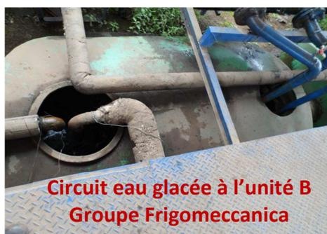
*Figure 1410 : circuit eau glacée exposé au soleil*
