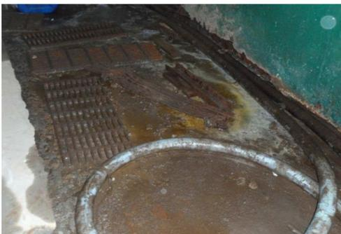
***Figure 12 : Rouille et eau usée***
