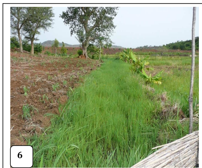
Photo 6: Drain primaire enherbé
