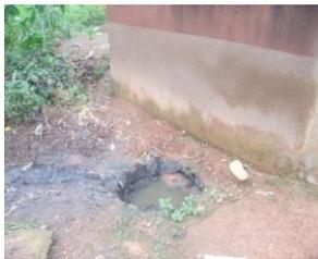
**Photo 5 puits perdu en mauvais état**
