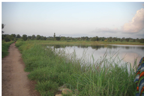
Photo 6 : Barrage de Perma
