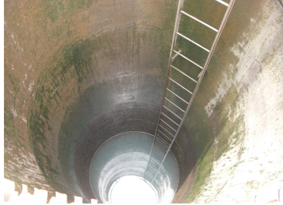
Photo 15 : Puits de Matéri (Vue de l'intérieur)
