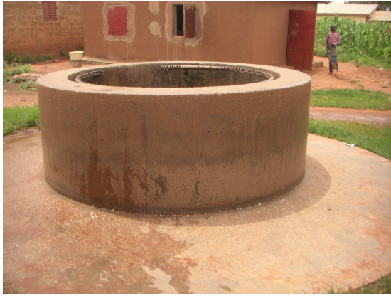
Photo 14 : Puits de Matéri (Vue de l'extérieur)
