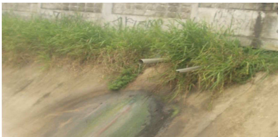
Figure9: Evacuation des eaux usées domestiques via les raccordements illicites
