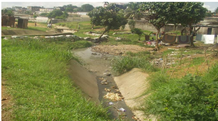
Figure4 : Prolifération de végétaux dans les canaux
