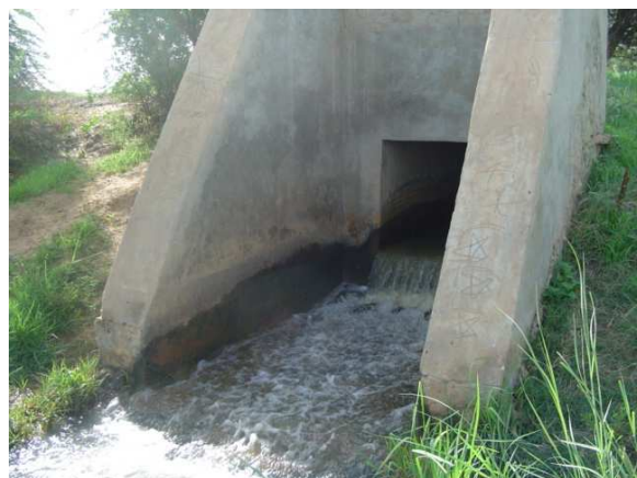
Photo 2: Déversement d'un canal de drainage d'eau d'eau usée agricole dans le Taoué
