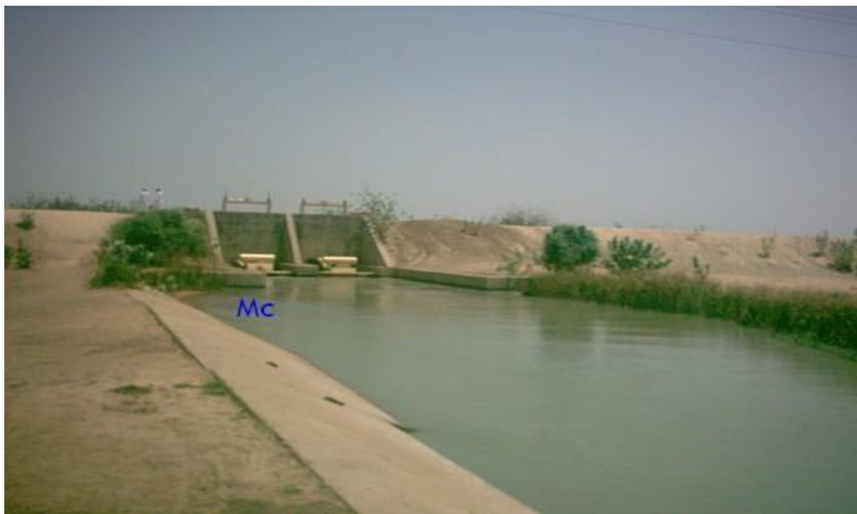
Photo 1: Vue du canal primaire du barrage de Maga
