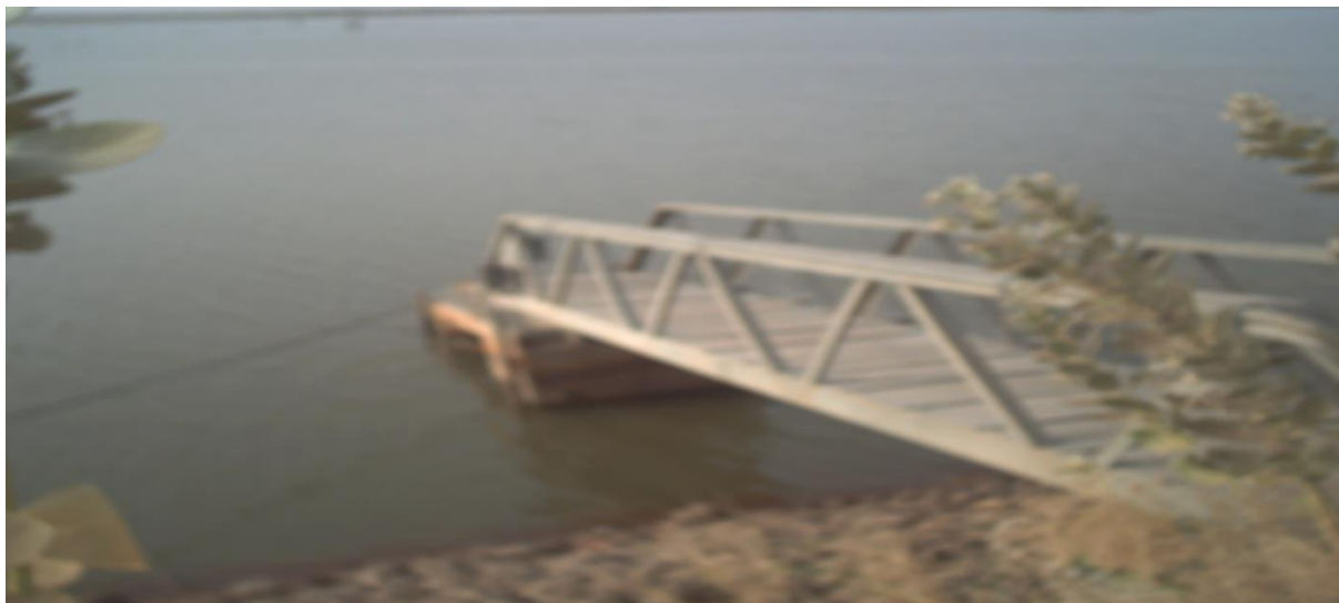
Photo 2: Prise d'eau de l'ONEA dans le barrage de Yitenga
