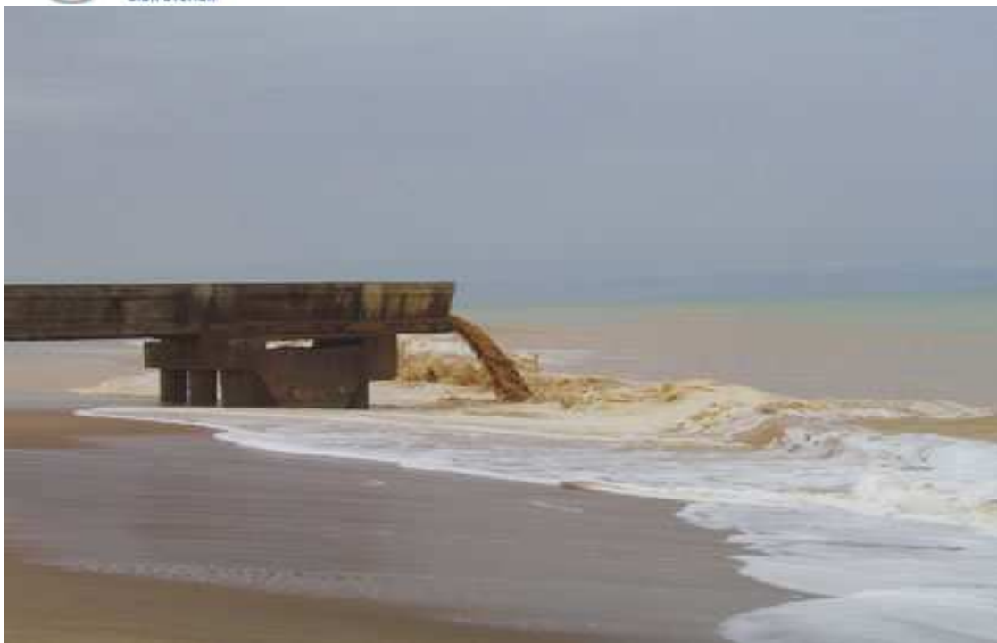
Figure 3 : Déversement des boues de traitement de phosphates dans la mer à Goumou-Kopé
