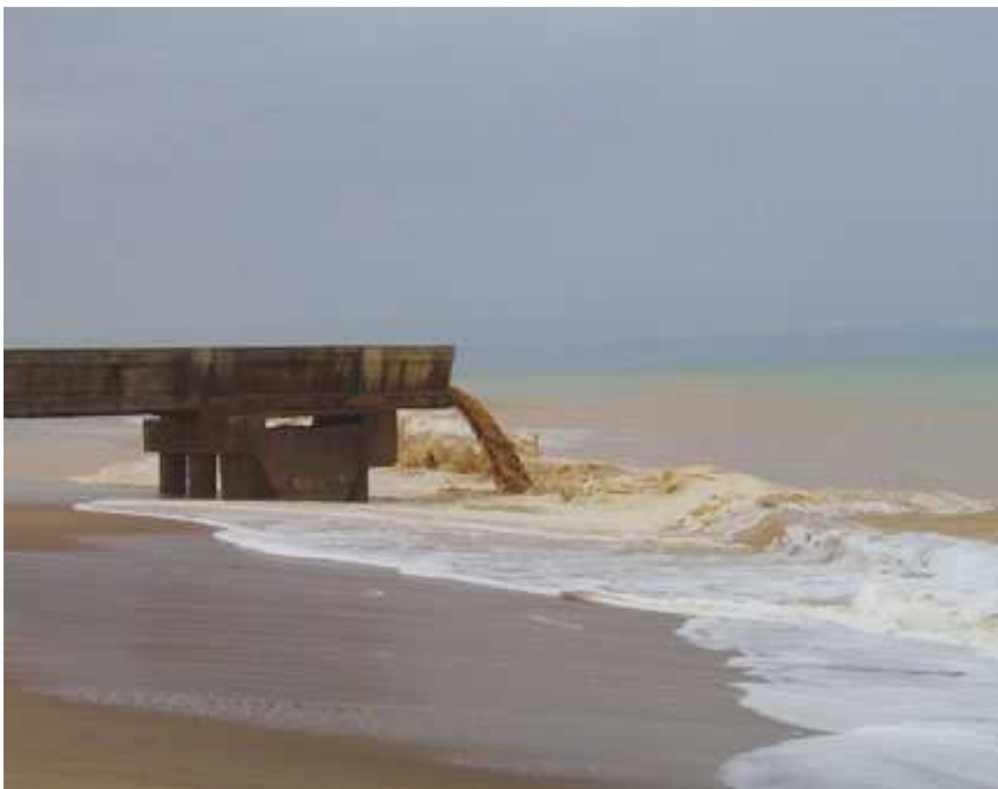
Déversement des boues de traitement de phosphates de l'usine de Kpémé dans la mer
