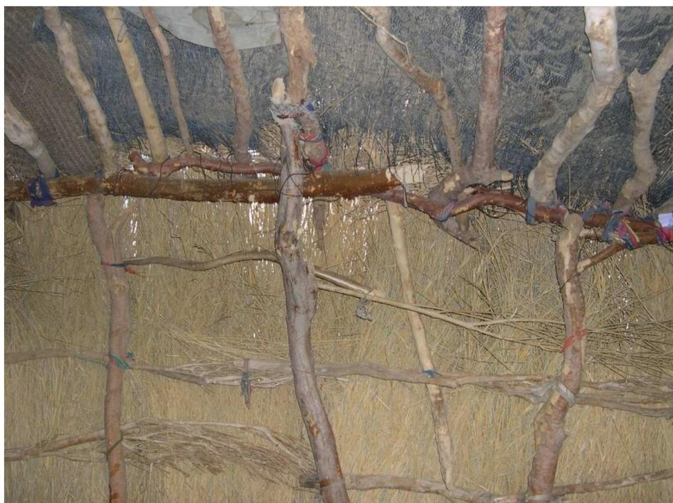
**PHOTO 4 :** Plusieurs espèces utilisées pour la construction d'un hangar
