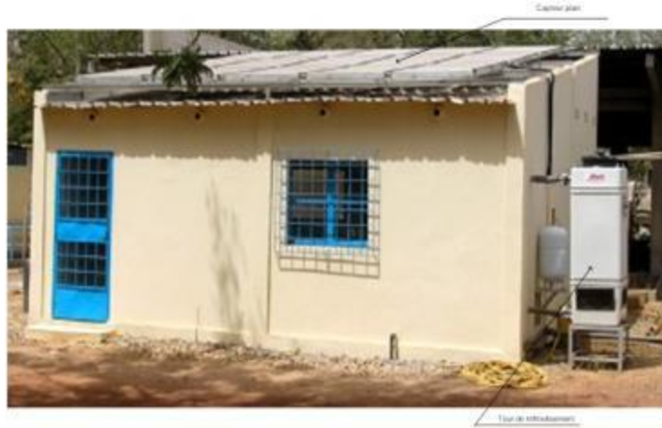
Photographie 1: Local clim sol
