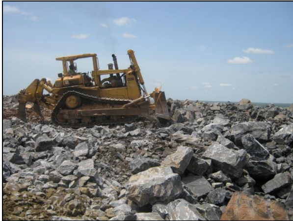
Photographie n°14 : Nivellement de la halde à stériles, (cliché A. KANTE, mine d'or de Morila, 2010)
