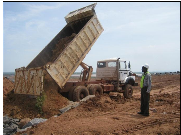
Photographie n°15 : Dépôt de terre végétale sur la halde à stériles nivelée, (cliché A. KANTE, mine d'or de Morila, 2010)
