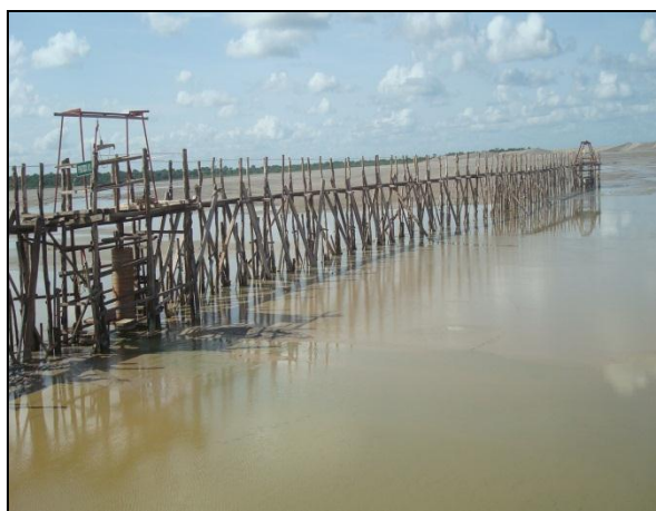
Photographie n°2 : Parc à boue ou Tailings Storage Facility (TSF), (cliché S. ILBOUDO, mine d'or de Morila, Août 2011)
