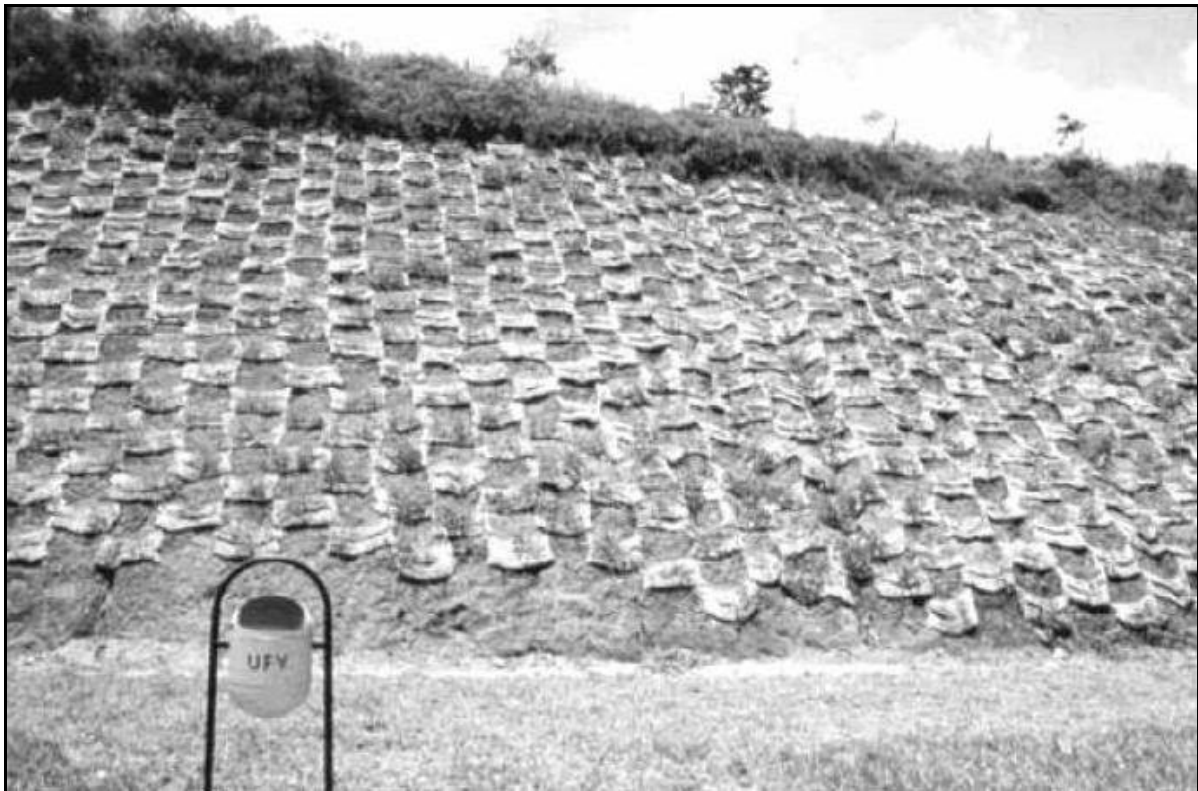
Photographie n°23 : Remise en végétation de talus fortement inclinés dans une mine de fer au Brésil, à l'aide de sacs de jute remplis de terre, d'engrais, de matières organiques et de semences
