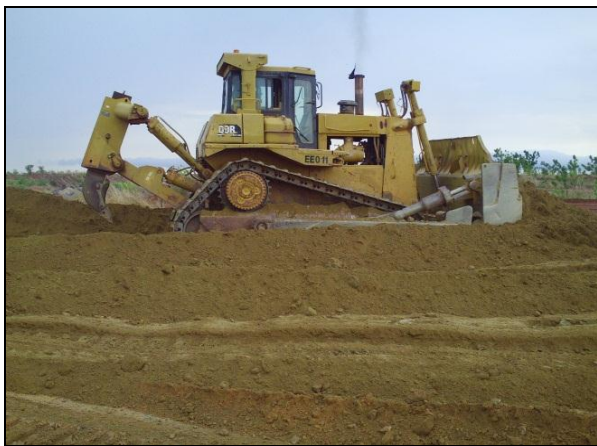
Photographie n° 17 : Epannage de la terre végétale, (cliché S. ILBOUDO, mine d'or de Morila, Juillet 2011)
