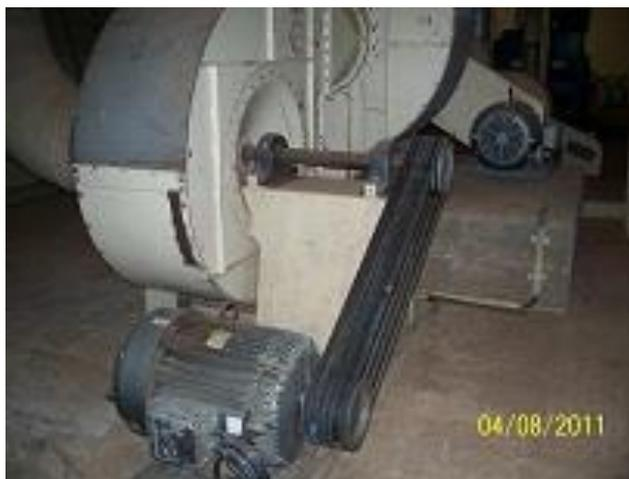
Figure 10 (Ventilateurs d'aspiration + Moteur)
