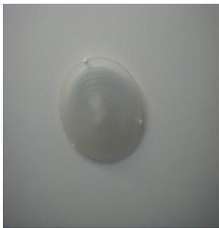
**Figure 11 :** Approximativement cent cinquante (150) lampes à incandescence de 60W maximum sont au faux plafond des salles de séjour et dans les chambres à coucher
