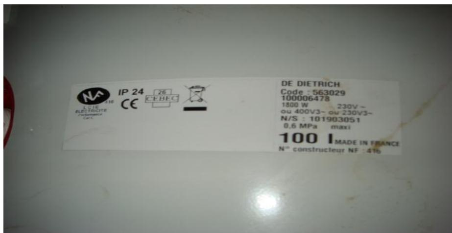
**Figure 13** : Caractéristiques de chauffe eau utilisée.
