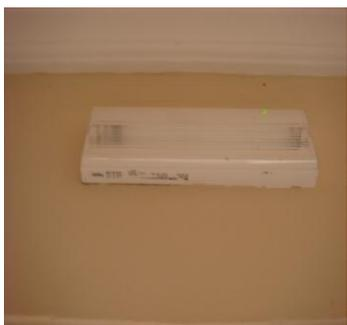
**Figure 12 :** Des lampes de sécurité se composent de 95 BAES de marque Rilux de 8W, soit une consommation de 760W.
