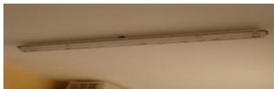
**Figure 8:** Quarante cinq (45) Lampes à tubes fluorescentes 120 cm de 60W avec ballast dans les couloirs et vérandas de la façade principale.
