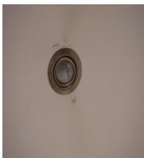
**Figure 10 :** Des lampes halogènes dichroïques de 60W pour l'éclairage de la salle d'attente au rez-de-chaussée, elles sont dix (10) au total.
