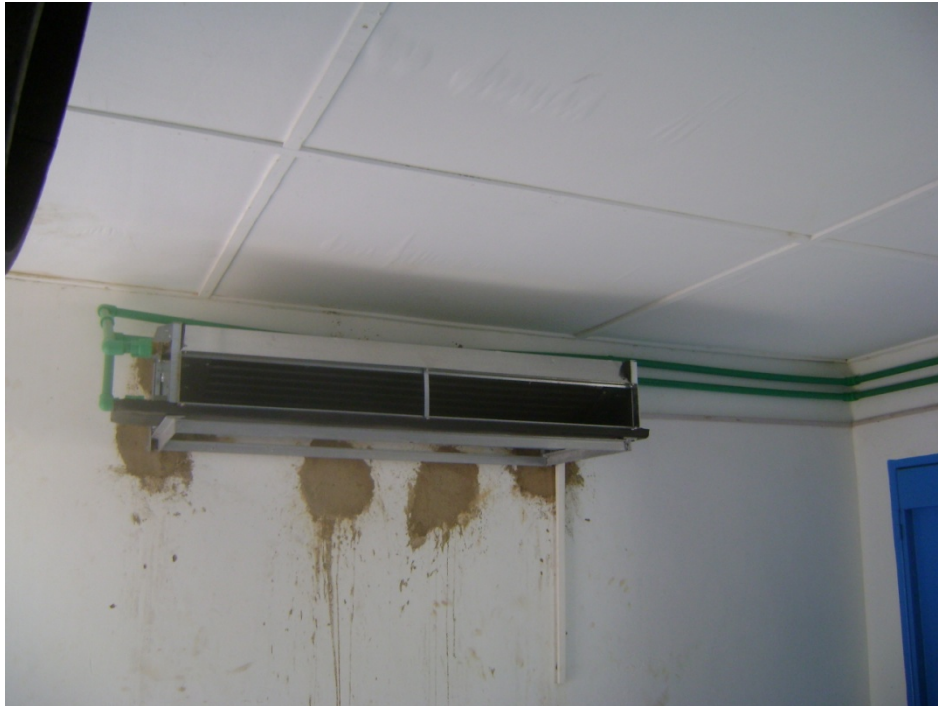
Figure 20: vue du montage du circuit d'eau glacée (ventilo convecteur)
