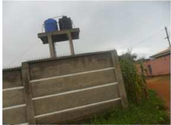
Réservoirs utilisés pour le stockage d'eau
