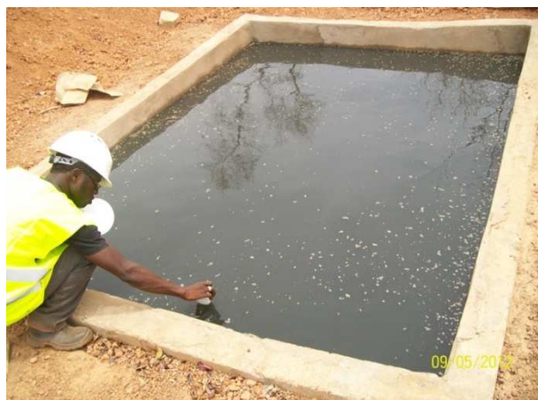
Photo 11 : Bassin de réception d'eau usée
