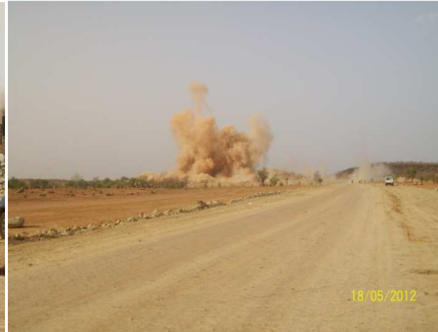
Photo 2 : opération de dynamitage au barrage
