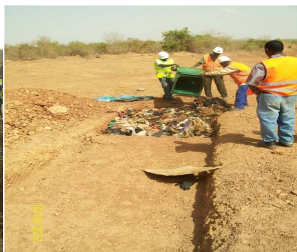
Photo 10 : Tranchée ouverte enfouir des déchets
