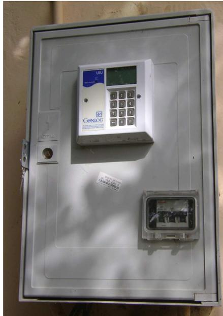
FIG.7 : Vue du Compteur électronique prépayé du SECADEV
