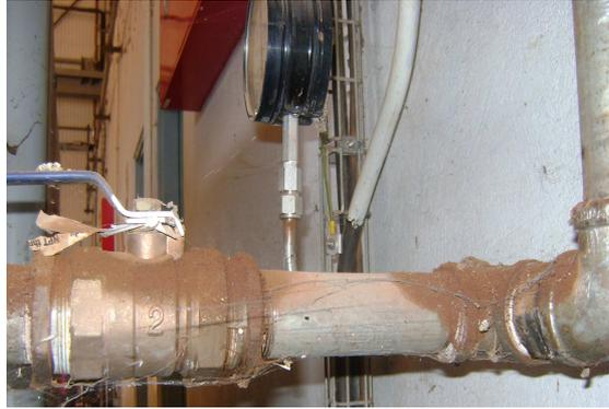
FIG.6 : PHOTO MONTRANT LES FUTITES D'AIR SUR LA TUYAUTERIE
