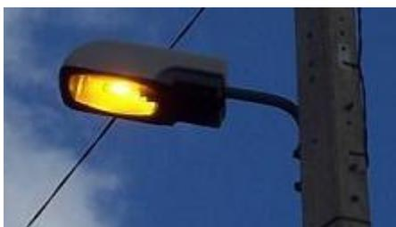
**Figure 9.** Un luminaire à lampe de sodium
