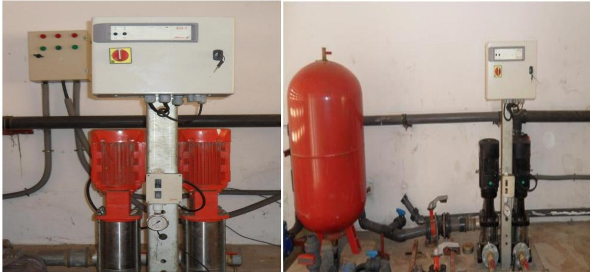
**Photo 4 :** Les pompes surpresseurs d'eau
