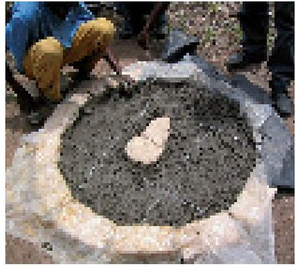
**Photo 3-8 :** Ciment et fils de fer barbelé dans le moule.
