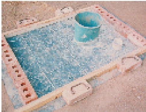
**Photo 4-6 : Un moule de dalle fait avec des briques et du bois.**
