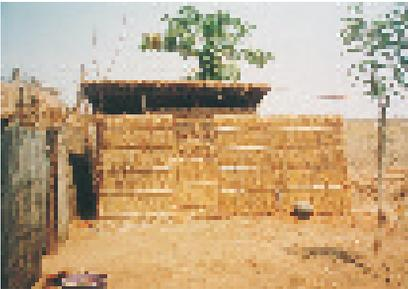
Photo 4-21 : Une *Fossa alterna* avec structure permanente
