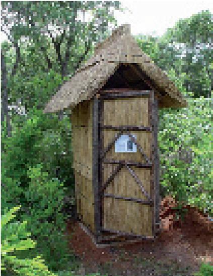
**Photo 3-1 : Latrine à compost simple construite sur une dalle rectangulaire.**
