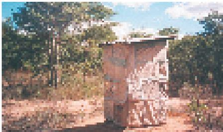
**Photo 3-57: Une structure mobile bâtie sur une armature de poteaux.**
