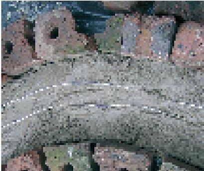
**Photo 3-31: Ajout de fils de fer pour renforcement.**
