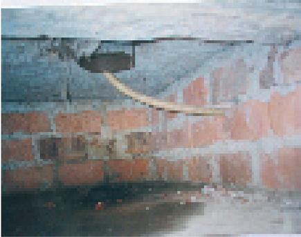
**Photo 6-37 :** Le tuyau en plastique achemine l'urine depuis le siège
