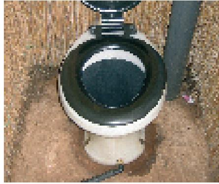
Photo 7-2 : Système de récupération des urines fixé à la base d'un siège
