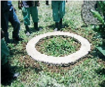
**Photo 3-35: Placement du soubassement de béton**
