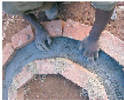
**Photo 3-44 : Ajout de fils de fer pour le renforcement.**
