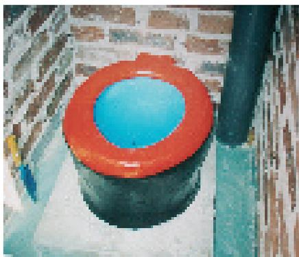
**Photo 5-6 : Siège de béton finalisé**
