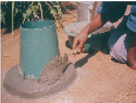
**Photo 5-1 : Construction du siège à faible coût.**
