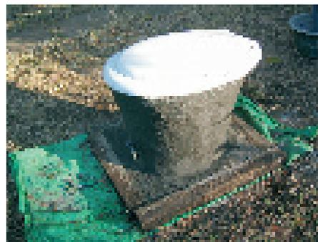
**Photo 6-24 :** Siège finalisé en durcissement
