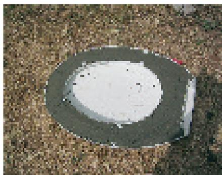
**Photo 6-17 : Béton ajouté au siège de latrine**
