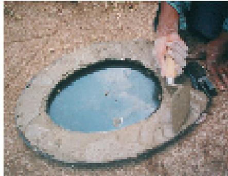
**Photo 5-8:** Le siège en plastique rempli de béton.
