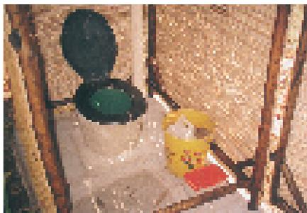
Photo 4-18 : L'intérieur d'une *Fossa alterna* équipée d'un siège
