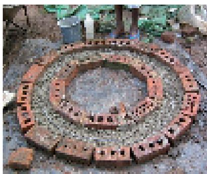
**Photo 3-15 : Renfort de ciment et de l'armature dans le moule.**
