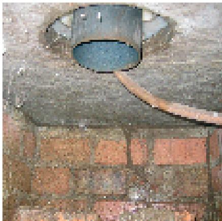
**Photo 7-14 : Le tuyau d'urine placé sous la dalle**
