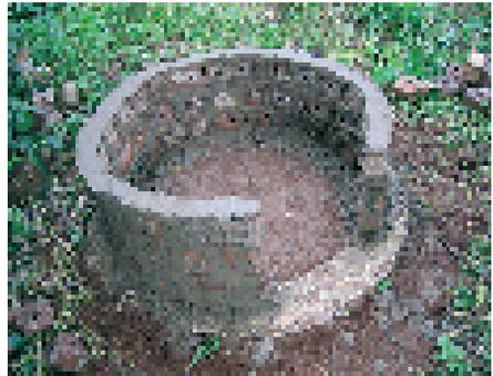
Photo 7-4 : Mur de brique bâti sur le soubassement
