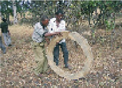
**Photo 3-45 : Déplacement du soubassement sec vers un nouvel emplacement.**
