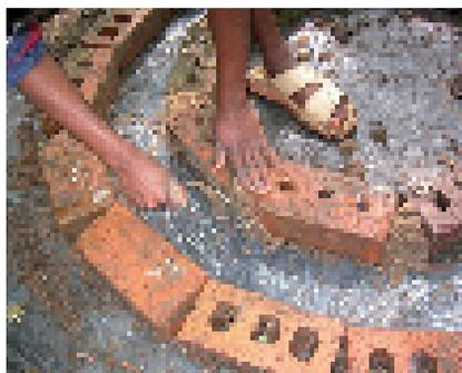
**Photo 3-14 : Remplissage de l'espace créé par les briques internes.**
