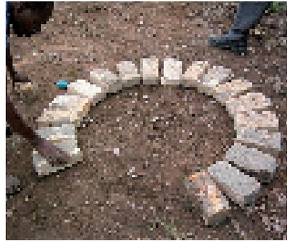
**Photo 3-10 :** Réalisation du soubassement en briques.
