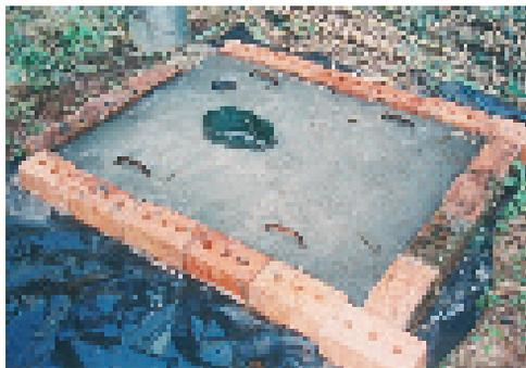
**Photo 4-7 : La dalle finalisée à l'intérieur du moule.**
