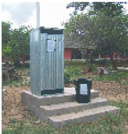
**Photo 4-27 : Une *Fossa alterna* avec une structure métallique**
