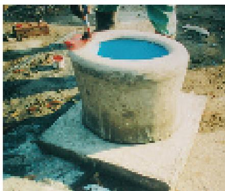
**Photo 5-5 : Peinture du siège de béton**
