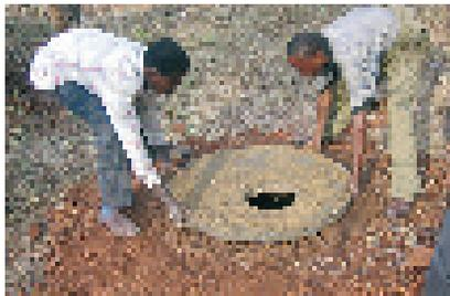
**Photo 3-49 : Pose de la dalle sur le soubassement**
