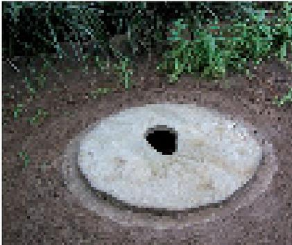
**Photo 3-20 :** Une dalle de latrine placée sur un soubassement.
