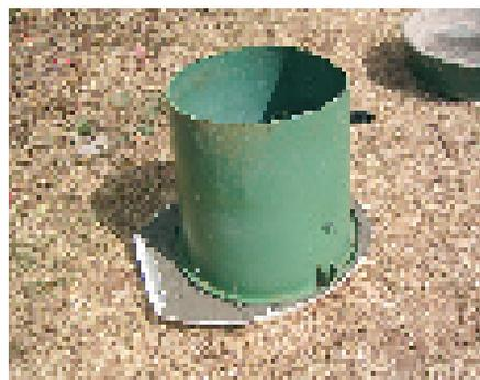
**Photo 6-18 : Seau placé sur le siège de latrine**
