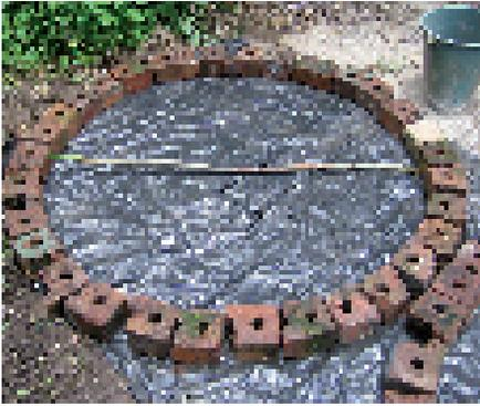
Photo 3-22 : Le moule pour la dalle de 1,15 m de diamètre
