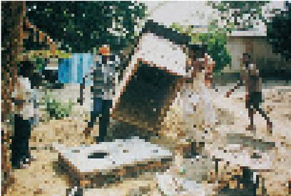
Photo 4-19 : Adaptation d'une superstructure mobile à une fosse de *Fossa alterna*.
