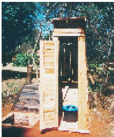
Photo 4-15 : La *Fossa alterna* utilisant une structure de bois
