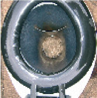
Photo 7-1 : Un siège à séparation d'urines adapté à une *Fossa alterna*
