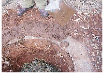
**Photo 3-48 : Mortier étalé sur le soubassement.**
