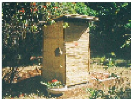
Photo 4-1 : Une cabine mobile faite de poteaux en bois et de paille
