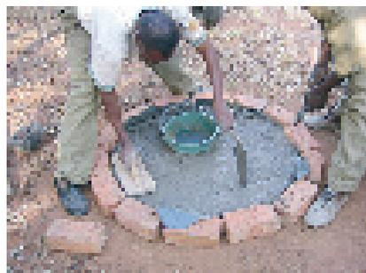
**Photo 3-42 : Nivellement du mélange de béton**
