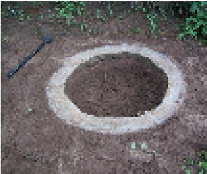
**Photo 3-18 : Creusement du trou à l'intérieur du soubassement.**
