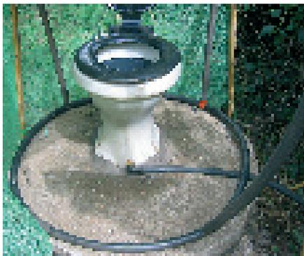
**Photo 7-8:** Le tuyau de déviation des urines attaché à la base d'un siège.
