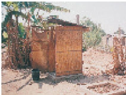
Photo 4-2 : Une cabine mobile avec cadre métallique
