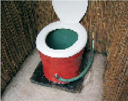
Photo 6-31 Siège à séparation d'urines installée.
