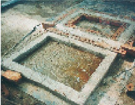
Photo 4-9 : Coffrage de soubassement en briques.
