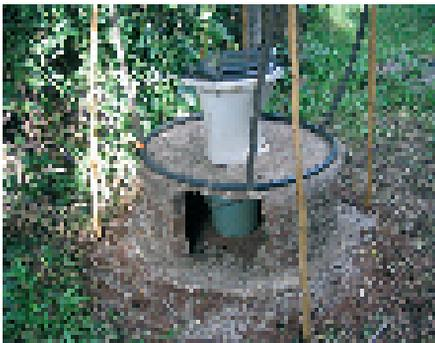
Photo 7-5 : Dalle et siège posés sur une base
