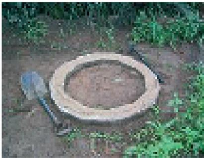
Photo 7-3 : Soubassement posé sur un terrain plat
