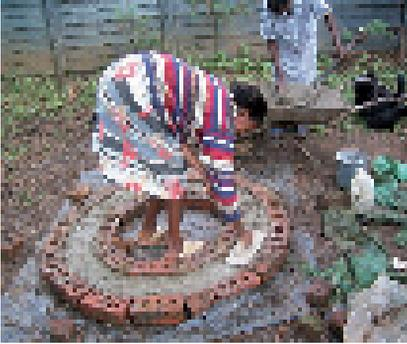
**Photo 3-16 : Nivellement du béton.**
