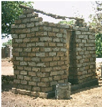
**Photo 4-28 : Latrine composteuse à double fosse avec une superstructure en briques**
