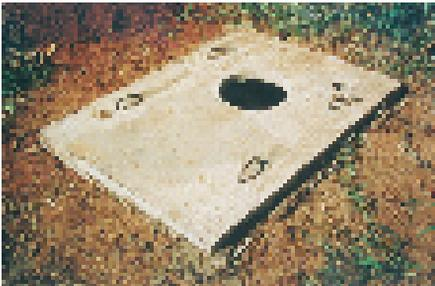
**Photo 4-13 : Pose de la dalle de béton**
