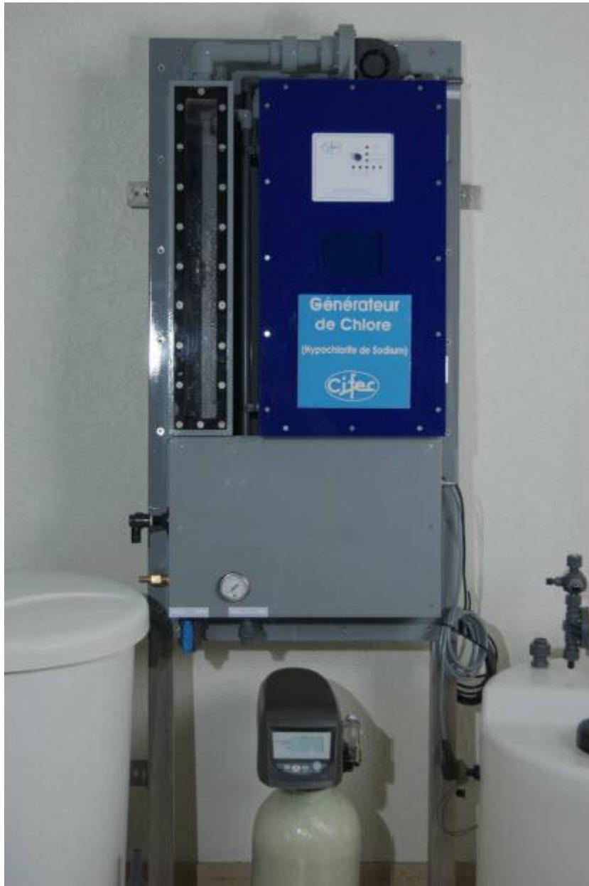
**Figure 19: Electrochlorateur (appareil générateur de NaClO)**
