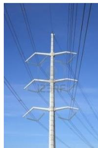
Figure 2 : Pylône tubulaire monopode
