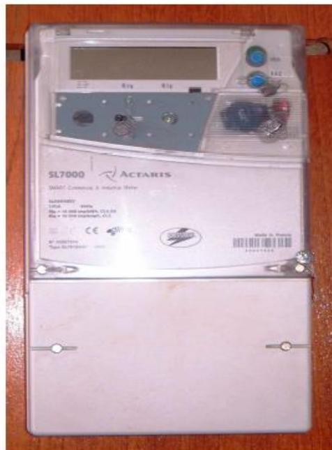
Figure 7 : Compteur électronique SL7000
