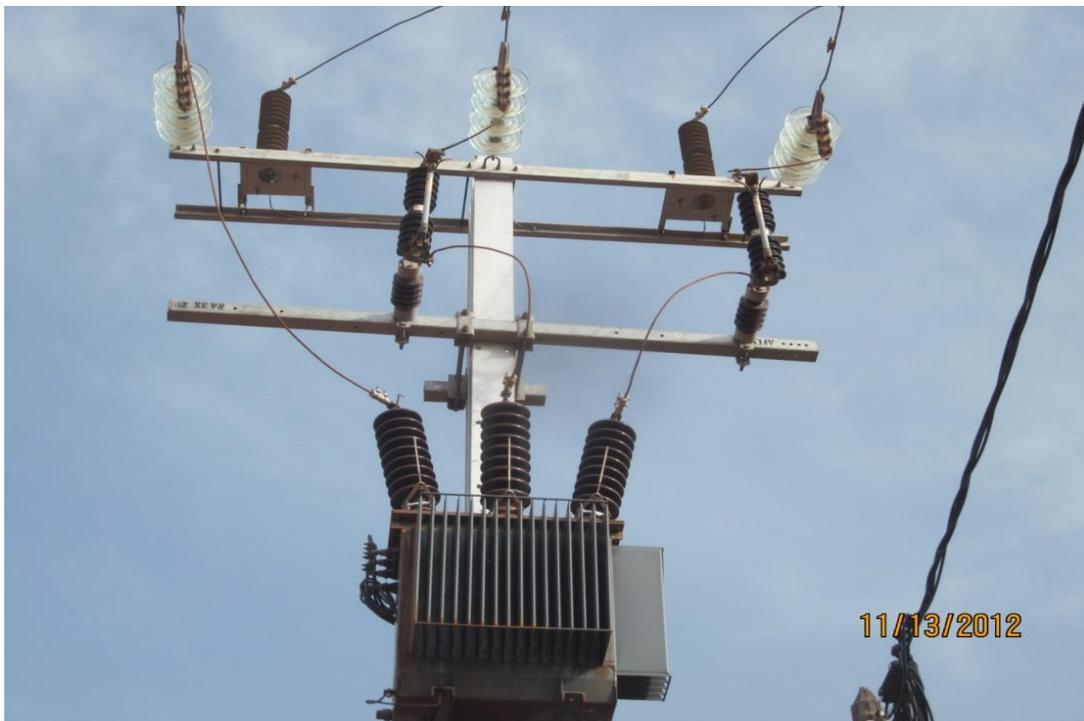
Figure 27: Transformateur 100kva sur le réseau de Sabou
