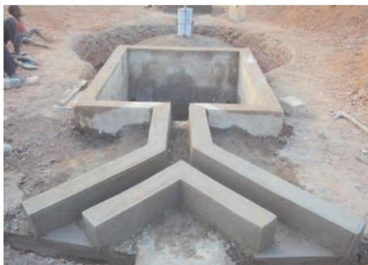
Figure 6: Digesteur en construction (PMO/PNB-BF dans SNV, 2012)
