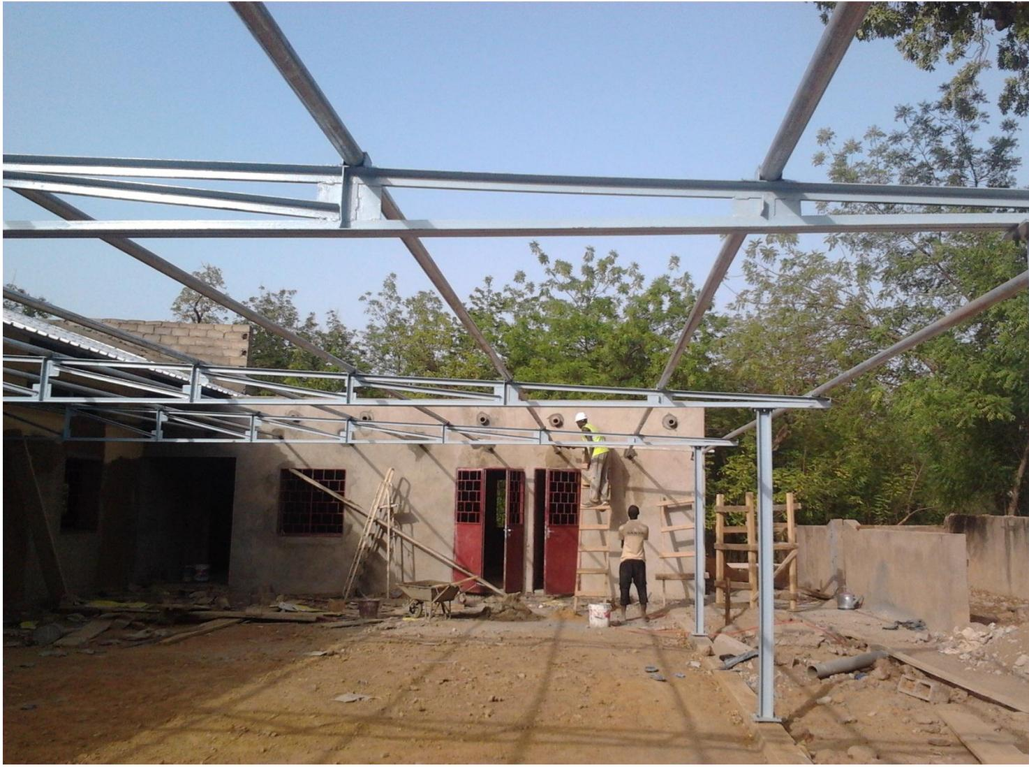
**Local annexe, poteaux métallique et poutres treillis et pannes en tubes ronds**
