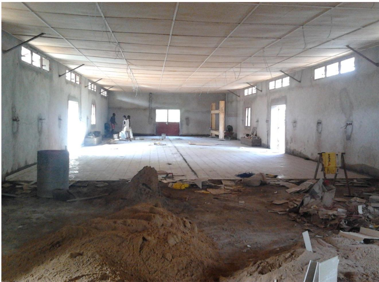
**Salle du bâtiment B (LEMC) : mise en œuvre du carrelage et du câblage électrique en cours**
