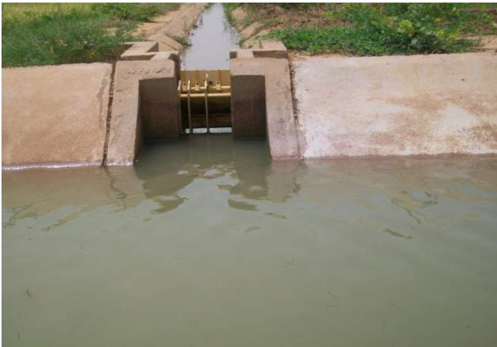
Photo 22 : module sous-alimenté fonctionnant en déversoir (Adjeffa, 21/10/2012)
