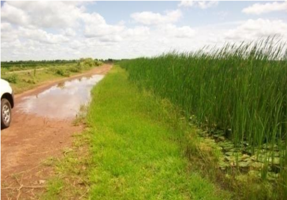
Photo 13 : débordement des eaux de drainage sur la piste (Adjeffa, 12/10/2013)
