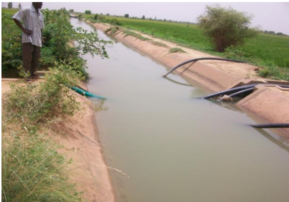
Photo 20: siphonage d'eau dans le laire (Adjeffa, 21/12/2012)
