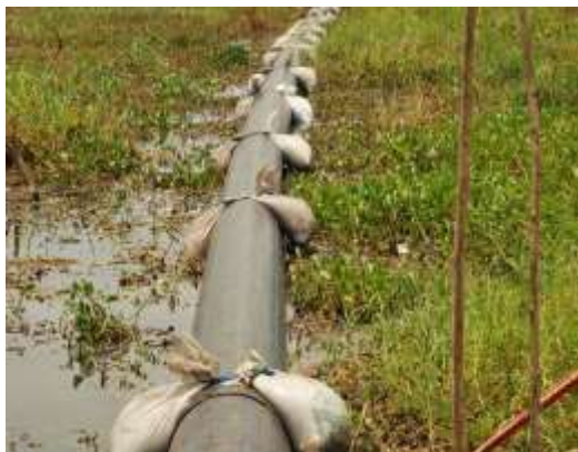
Photo 1 : Lestage provisoire de sable
