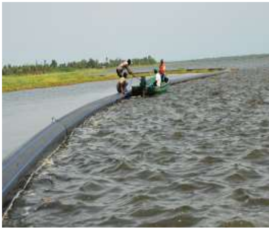
Photo 7 : Conduite bardée sur l'eau
