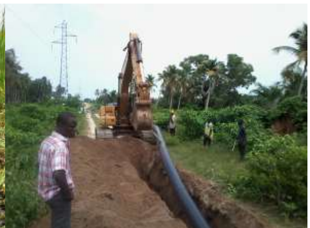
Photo 10 : Pose à l'engin
