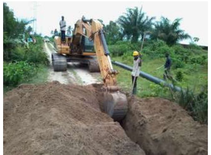
Photo 8 : Fouille à l'engin
