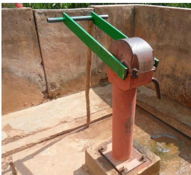
Figure 8: pompe à motricité humaine avec bras
