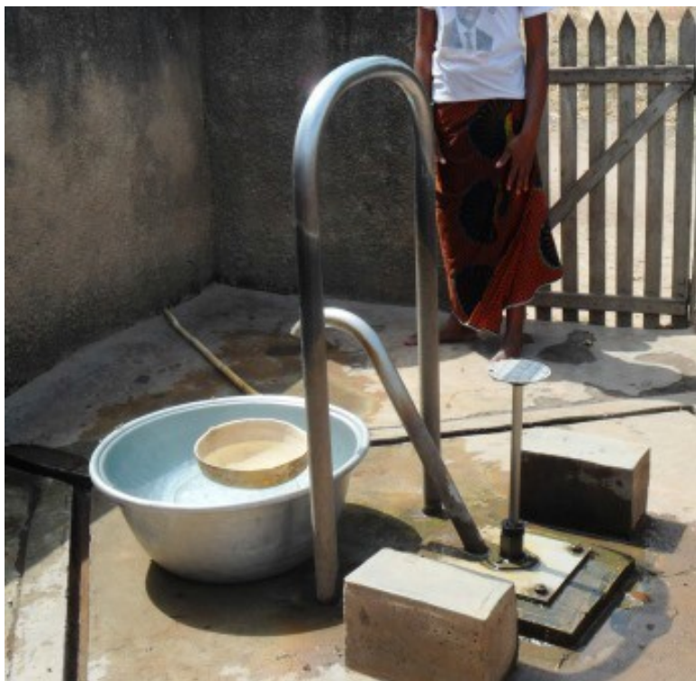
Figure 7: pompe à motricité humaine avec piston
