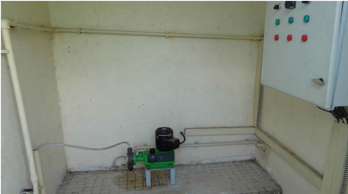
Figure 13: Une pompe doseuse (Bondoukou)
