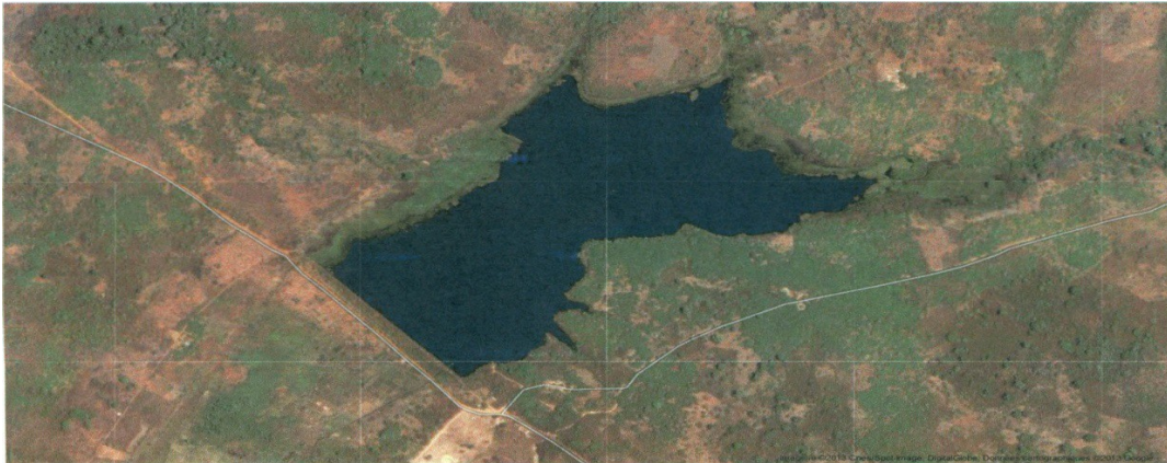
Figure 16: Le barrage de Songori (Vue de dessus).
